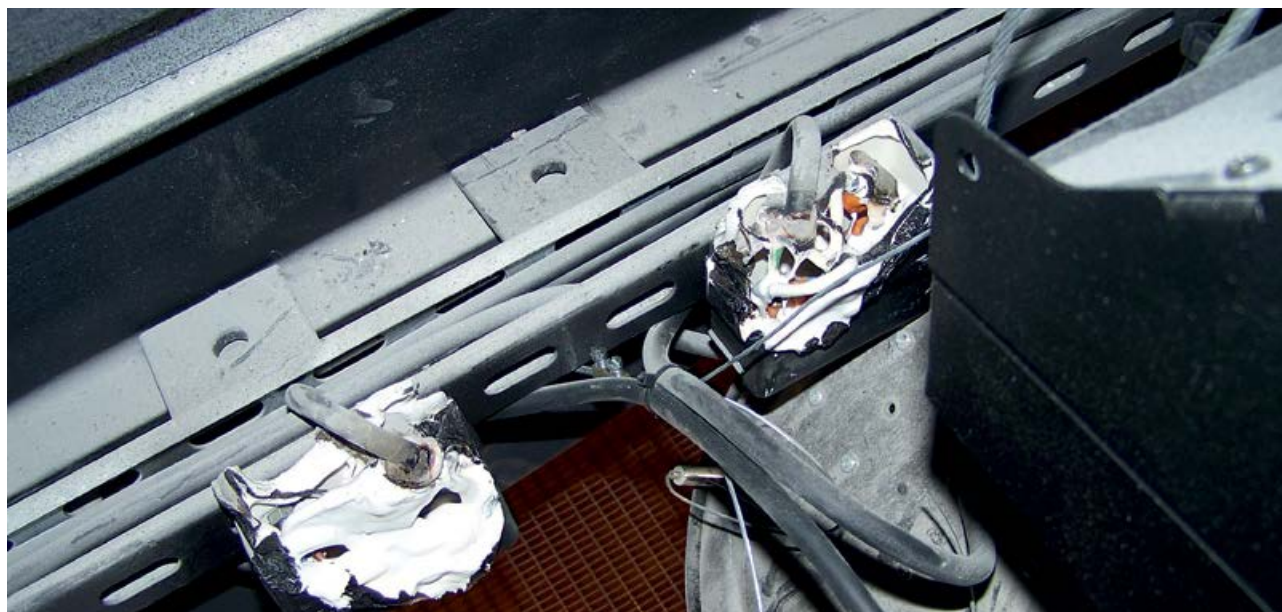
Pięknie ulepszone gniazda Schuko, którym dane było przeprowadzić więcej prądu niż chciały.
